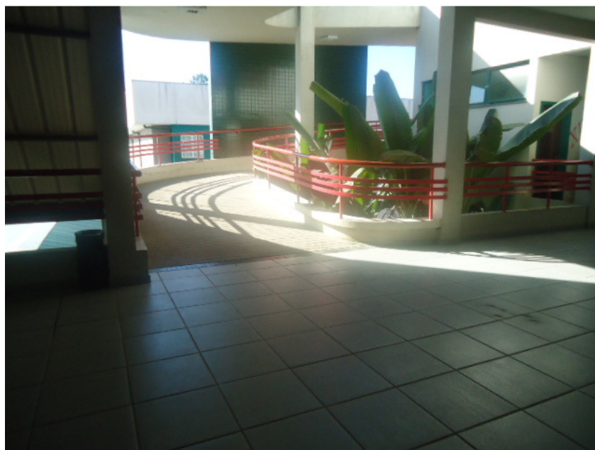
1º andar – acesso 2º andar
