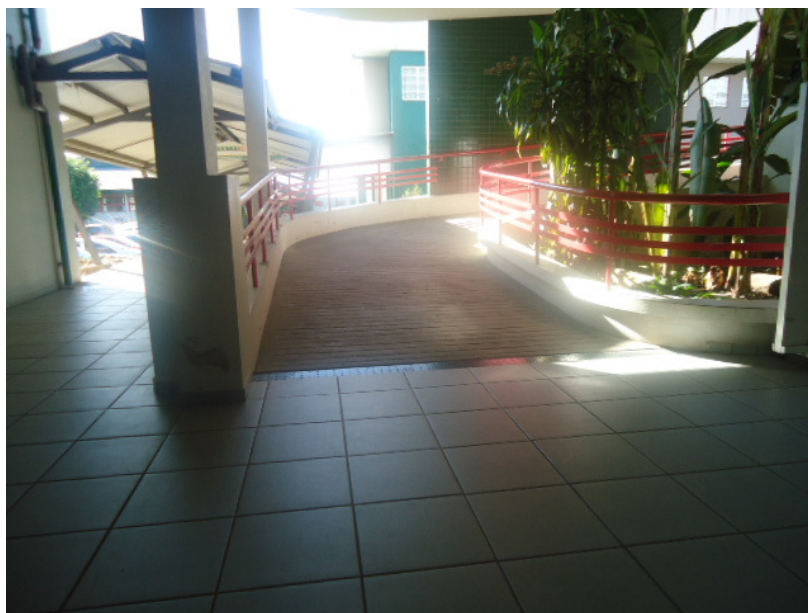
Piso Térreo – Acesso 1º andar
