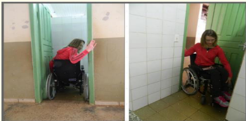
Figura 9 – Dificuldades de acesso aos sanitários
