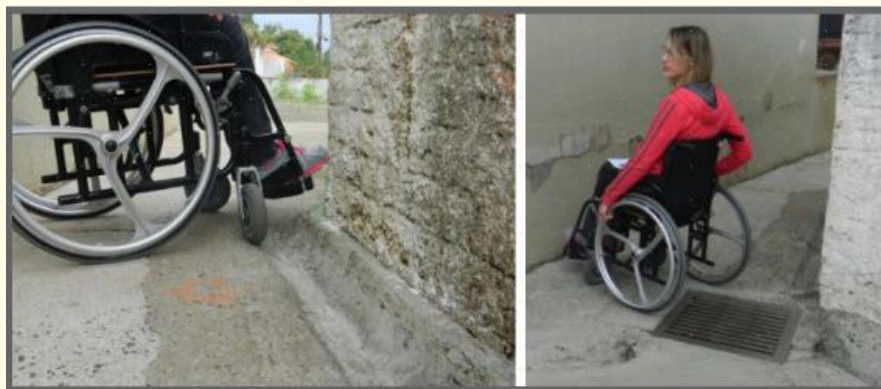
Figura 13 – Corredor de acesso à quadra de esportes
