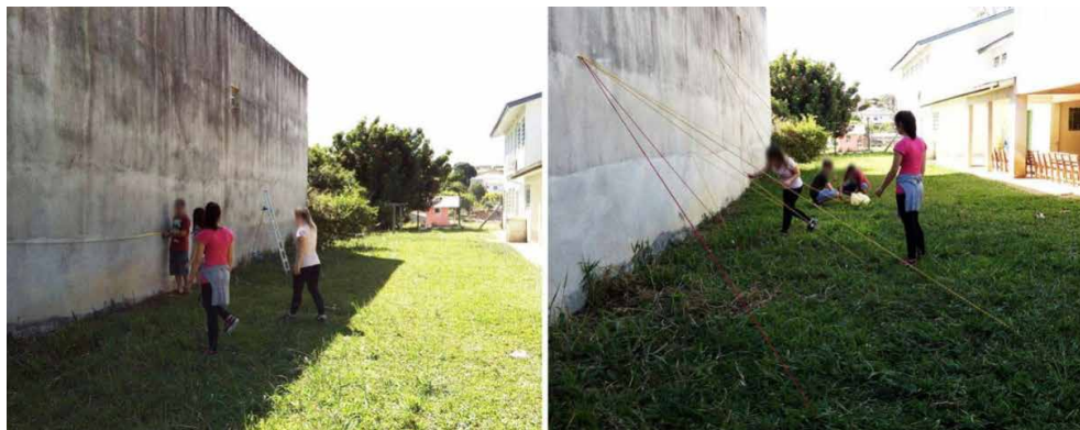
Figura 10 - Projeto do jogo de cordas sobre a empena sega sendo montado na escola. Esq.: Locação do projeto, medidas sendo tomadas. Dir.: Finalização do projeto, tensionando as cordas fixação no chão
