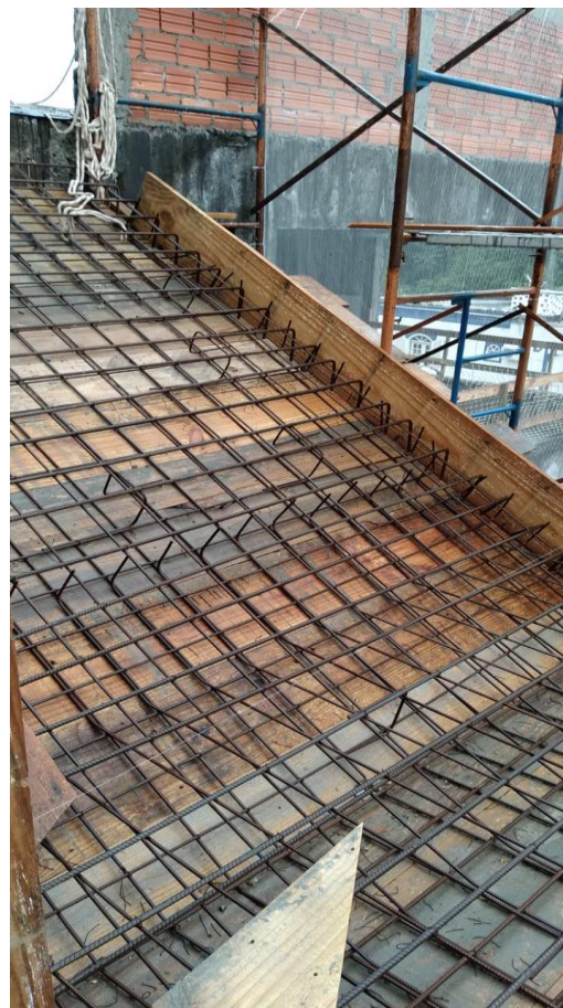
FOTO 27 – Armadura escada.
