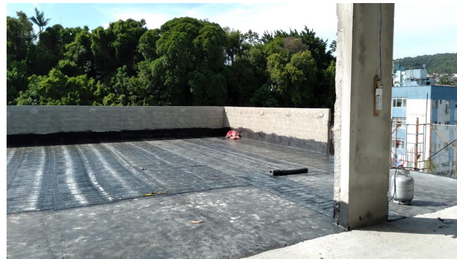
FOTO 21 – Impermeabilização terraço.
