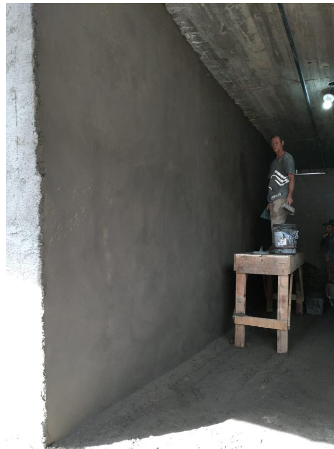
FOTO 02 – Reboco subsolo.
