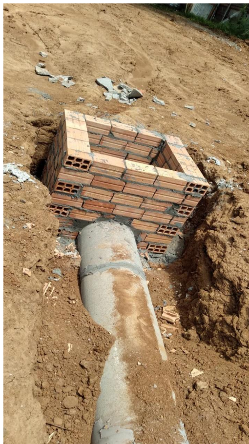
FOTO 09 – Drenagem estacionamento.
