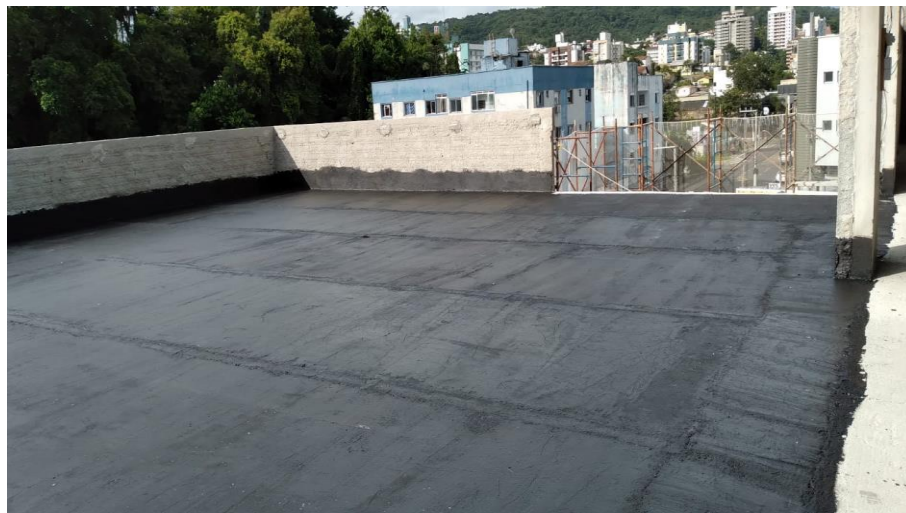
FOTO 20 – Impermeabilização terraço.
